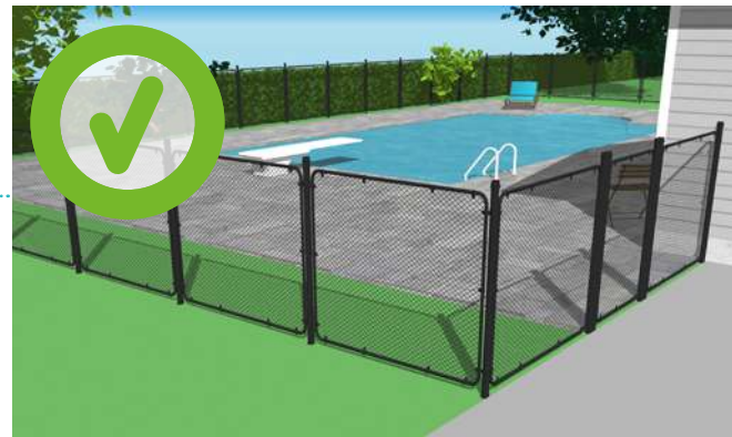
Exemple de clôture en mailles de chaîne dont la largeur est de moins de 30 mm.
